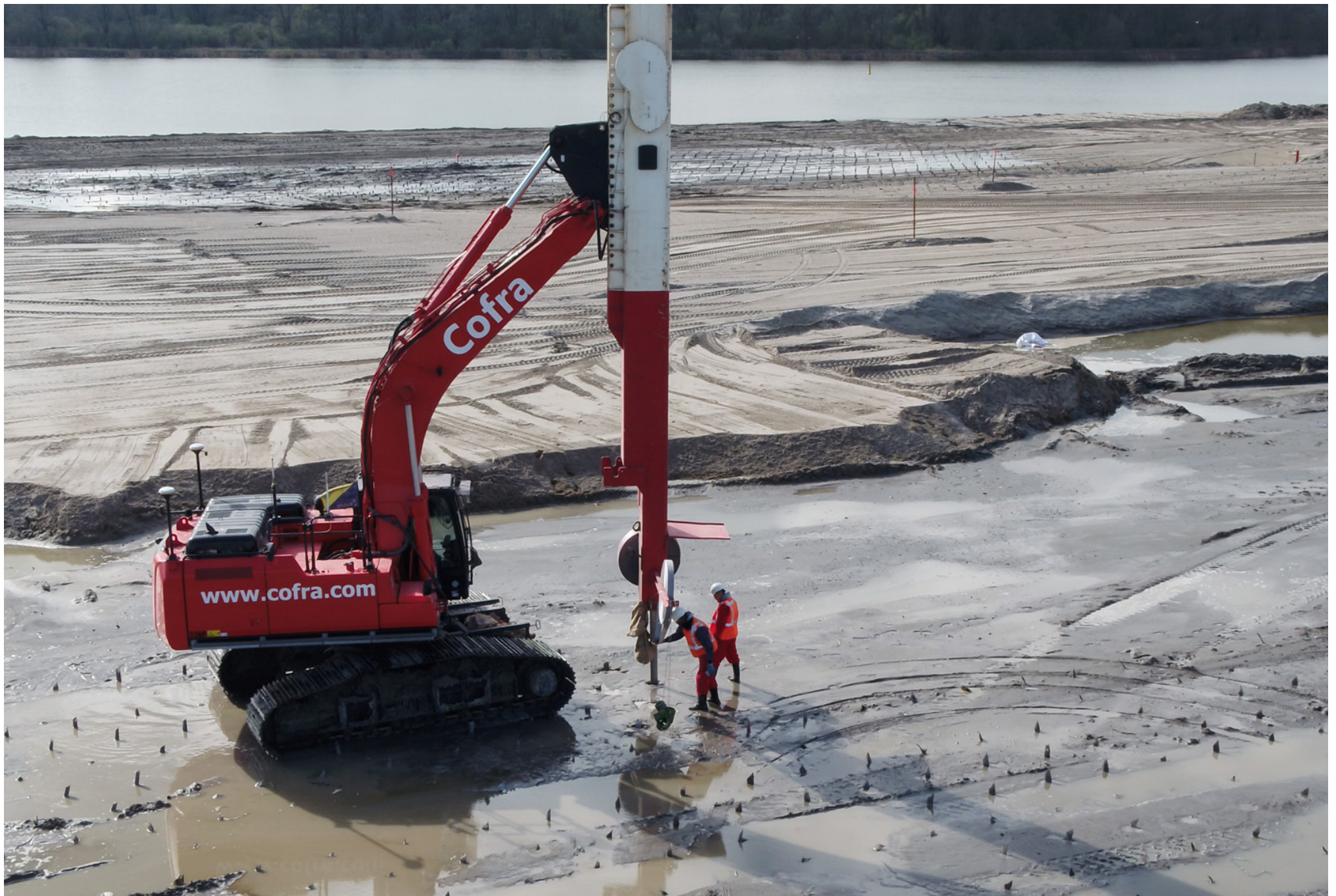
Afb. 10.1 Het land maken van Strandeiland is gestart in augustus 2018
