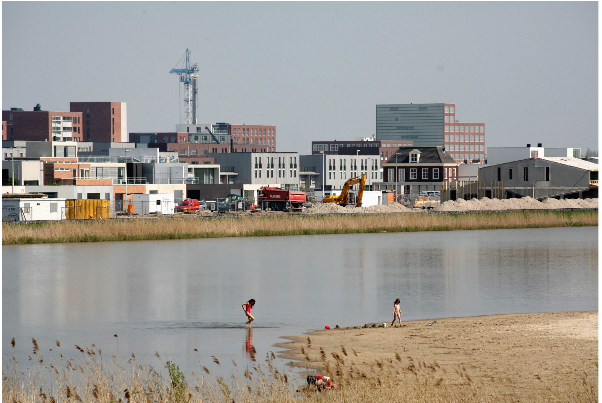
Afb. 6.1 Haveneiland in aanbouw (2006). Amsterdam Oost
