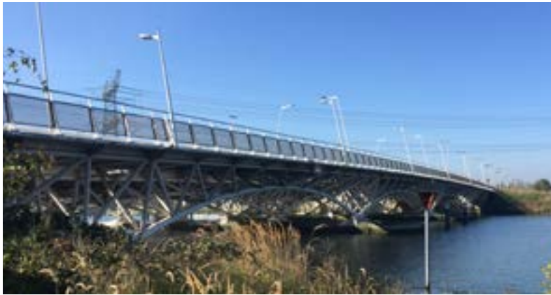
Afb. 5.8 Brug 2002 tussen Steiger- en Haveneiland, Amsterdam Oost
