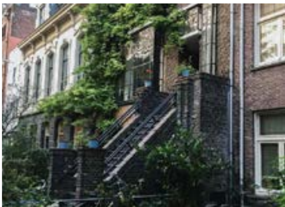
Afb. 6.4 Margestroom met trappen. H. Polaklaan, Amsterdam Centrum
