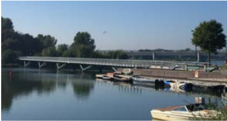
Afb. 5.7 Brug 2037 van Steigereiland naar de Diemerzeedijk, Amsterdam Oost
