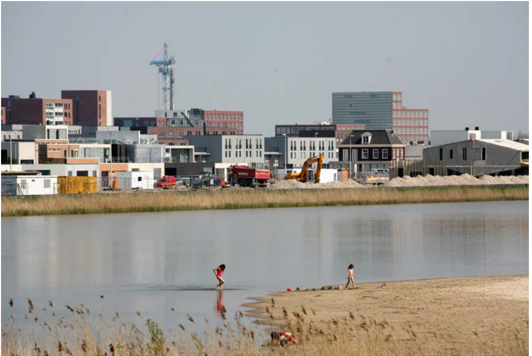
Afb. 6.1 Haveneiland in aanbouw (2006). Amsterdam Oost
