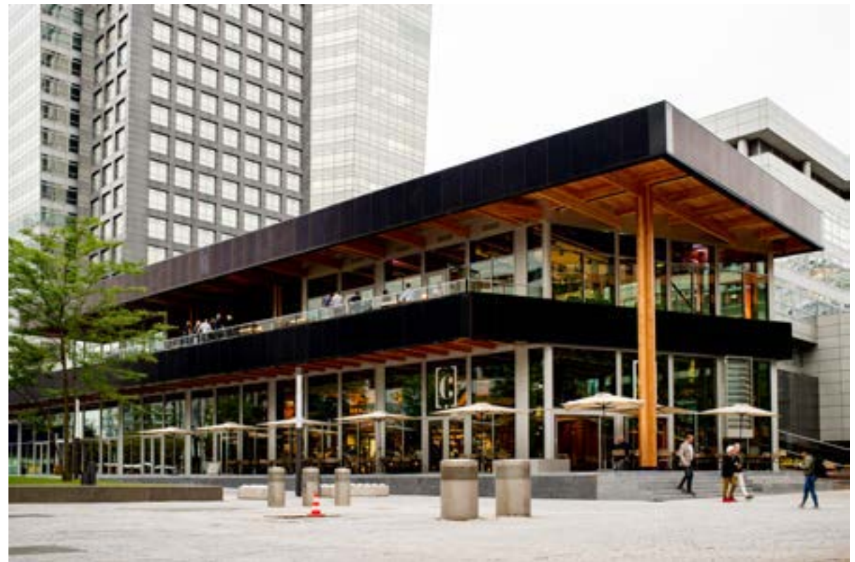
Afb. 8.6 Circulair gebouw CIRCL van ABN AMRO op de Zuidas, Amsterdam Zuid
