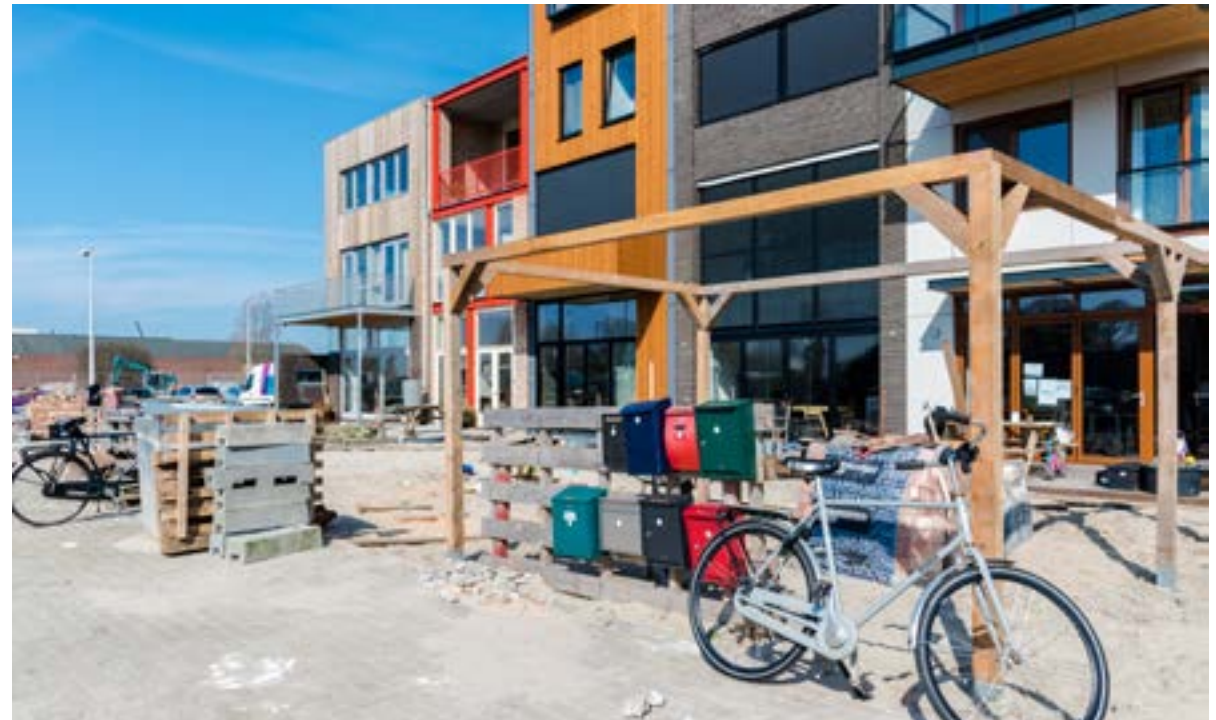
Afb. 11.7 De gemiddelde woningdichtheid van de 1 e fase bedraagt circa 60 woningen per hectare. Buiksloterham, Amsterdam Noord
